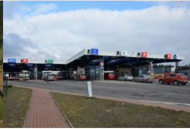
Widok na przejście dla aut osobowych
