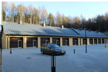
Widok na parking pojazdów służbowych
