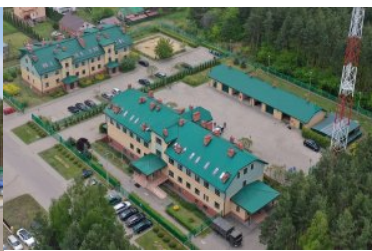
Widok na placówkę z lotu ptaka
