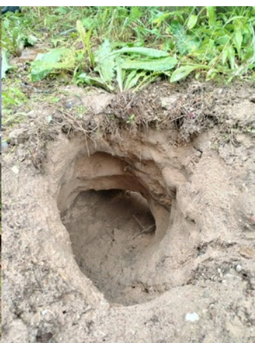
Podkop pod zaporą
