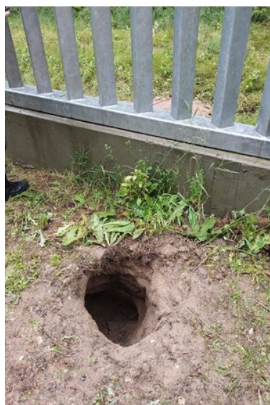
Podkop pod zaporą
