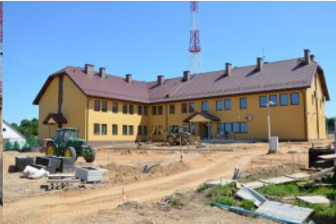
Nowe obiekty Placówki SG Nowym Dworze
