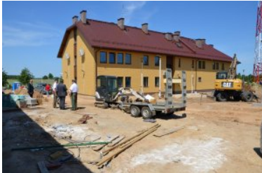
Nowe obiekty Placówki SG Nowym Dworze
