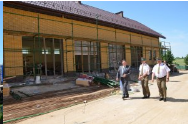
Nowe obiekty Placówki SG Nowym Dworze
