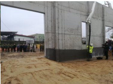
Wmurowanie aktu erekcyjnego pod budowę stacji obsługi pojazdów
