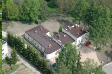
Widok na placówkę z lotu ptaka
