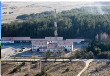
Widok na placówkę z lotu ptaka
