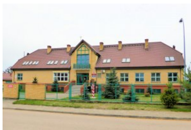
Widok na cały budynek
