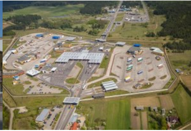
Widok z lotu ptaka na przejście graniczne
