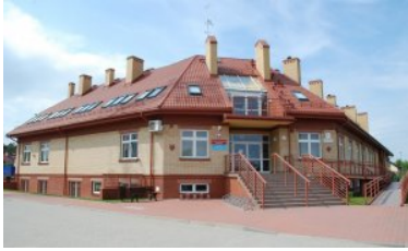
Widok na cały budynek.
